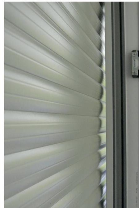
Abbildung 30: Panzer, der „ausbaucht“. Die Rollladenstäbe wölben sich nach vorne.
