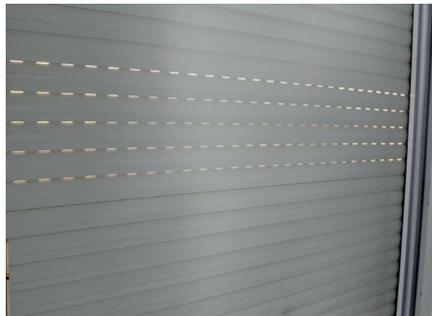
◀ Abbildung 17 + 18: Panzer mit offenen Lichtschlitzen im herabgelassenen Zustand. (Quelle: Hella)
