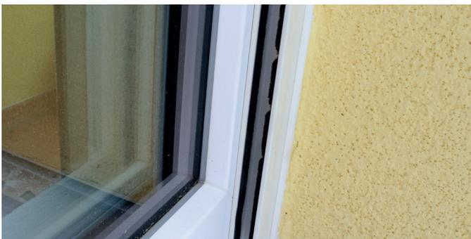
Abbildung 24: Der Keder ist teilweise so stark eingedrückt, dass er sich nicht mehr in seine ursprüngliche Form zurückstellt.
