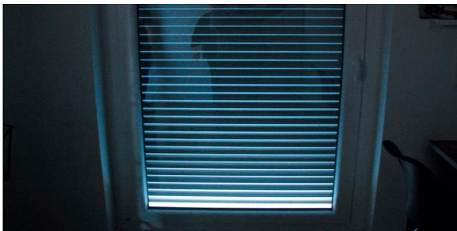
Abbildung 14: Indirekter Lichteintrag über die Fensterbank. Hier sitzt der Rollladenpanzer auf den Endkappen der Führungsschienen auf. Diese Ausführung wurde im Vorfeld vertraglich vereinbart.
