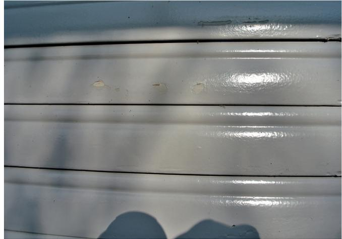
Abbildung 13: Fehlstellen in der Lackierung eines Holzrolllades.
