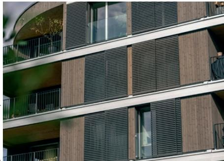
Funksystem Somfy iO gesteuert, das problemlos in jede Gebäudeautomation eingebunden werden kann. Dabei haben die Bewohner alle Bedienoptionen zur Auswahl. Standardmäßig wird jedes Element einzeln über einen Handsender gesteuert. Alternativ können die Schiebeläden über einen Sonnenwächter automatisch in Abhängigkeit von der Sonneneinstrahlung geöffnet und geschlossen werden.
